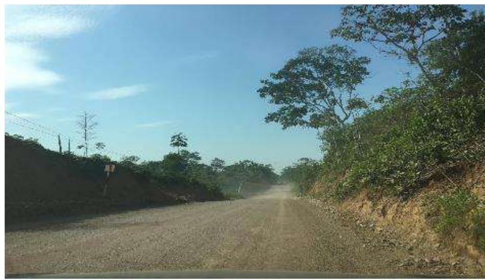
**Foto 3:** SUBRASANTE, MATERIAL DE SUB BASE COLOCADO
